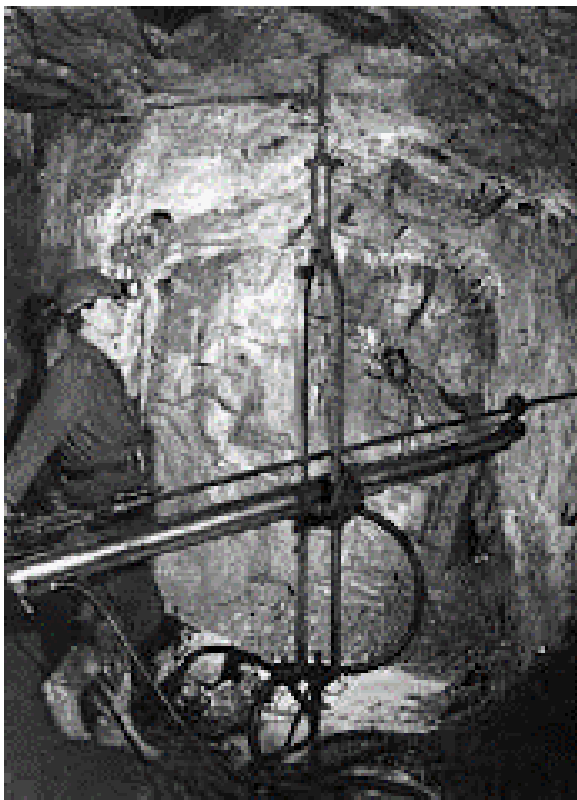
Установка переносная бурильная (УПБ-1Б)
